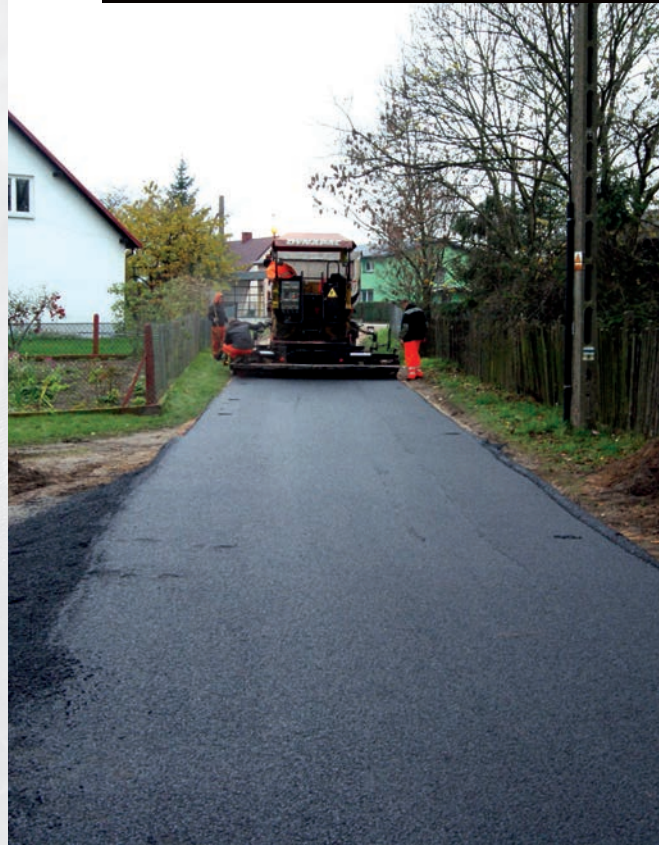
Prace remontowe na ul. Ogońskiej w stronę drogi powiatowej
